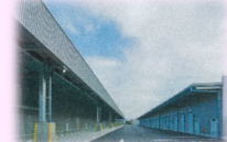
温度管理に対応し、効率的に作業できる買荷保管積込所
