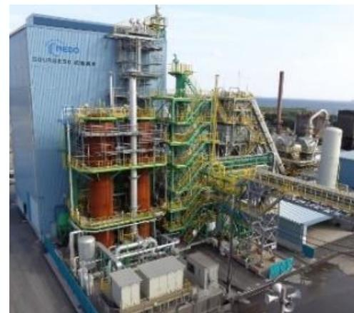
12m<sup>3</sup> 小規模試験高炉(水素還元)
