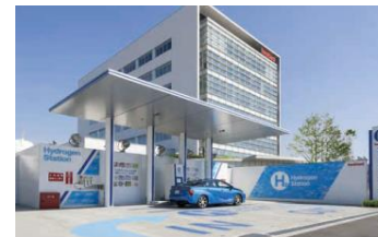
水素ステーション
