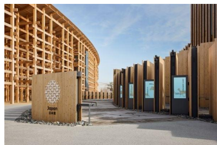
日本館・大屋根リング
