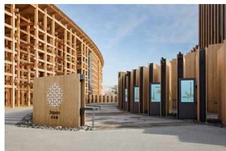
日本館・大屋根リング
