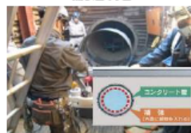
例：管路の耐震補強
