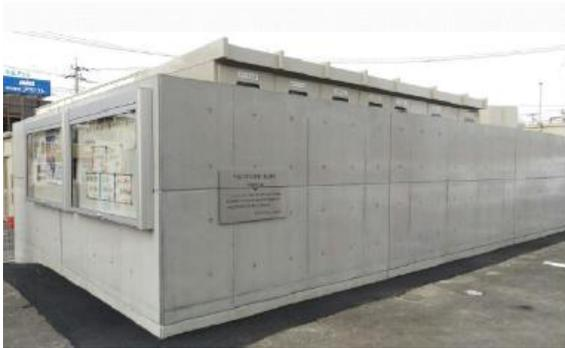
写真：コンクリート壁で浸水対策を施した非常用発電設備
