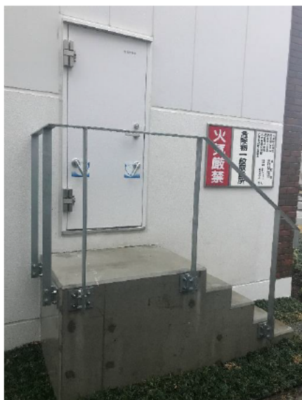
■ 塀に設けた防水扉
