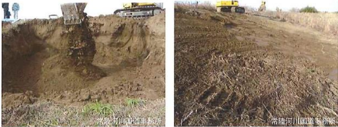
写真5 天地返しと整地後の状況（那珂川）
