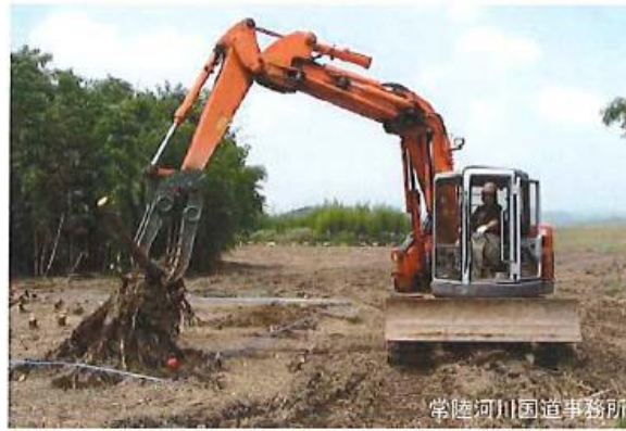
写真3 バックホウ等による試験抜根（久慈川）
