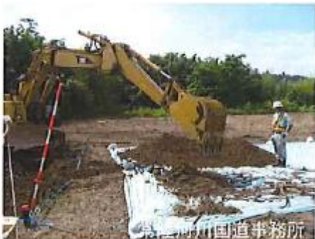
スケルトンバケットによる除根
