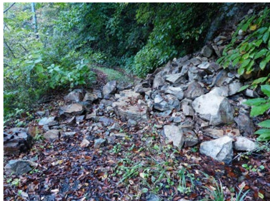
土砂崩壊の様子
