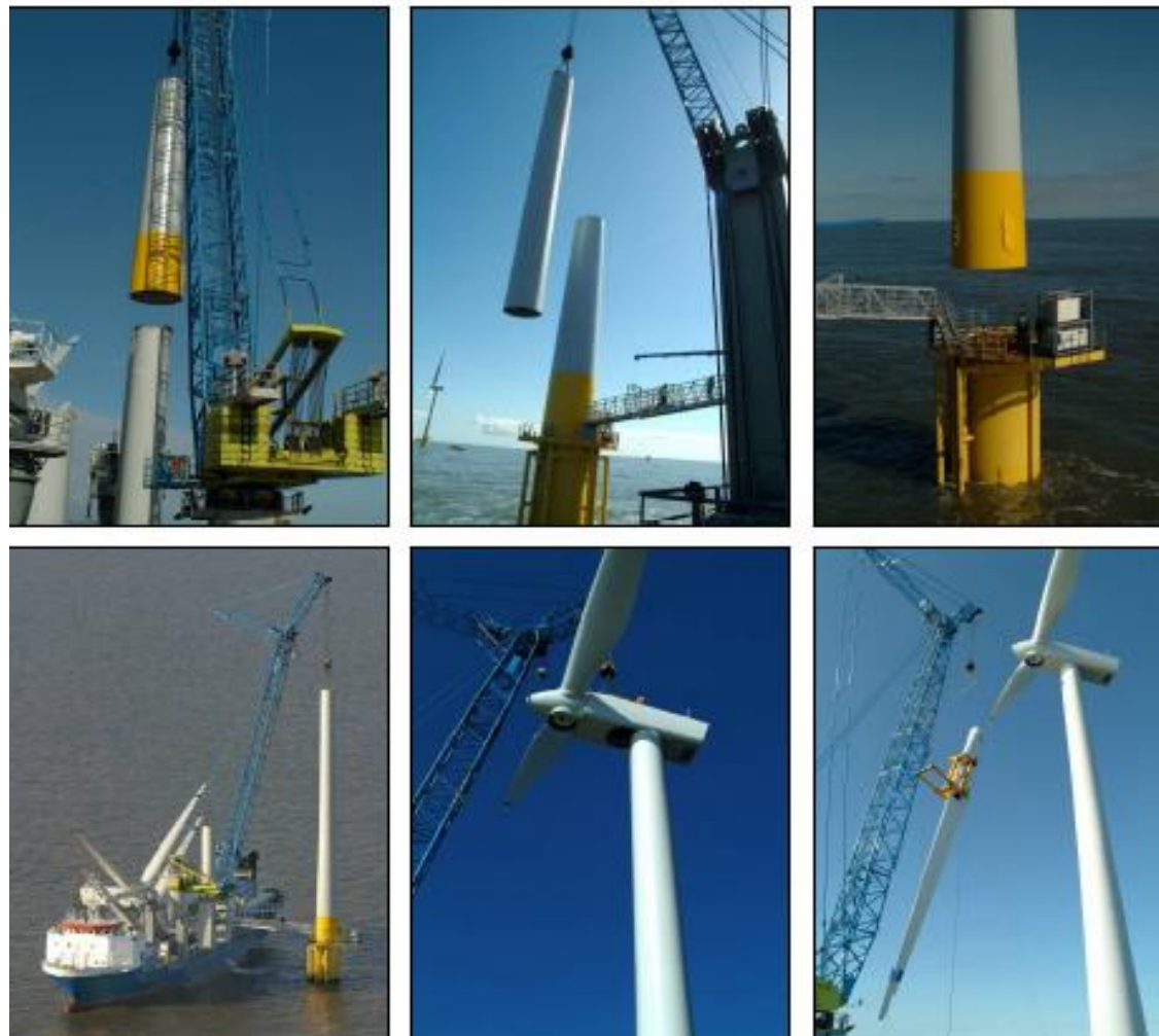
風力発電機の据付作業
