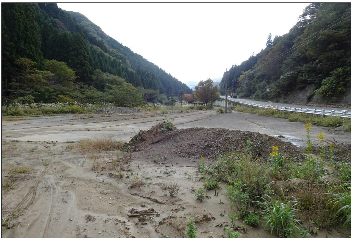
写真 4(2) 積替え場候補現地状況
