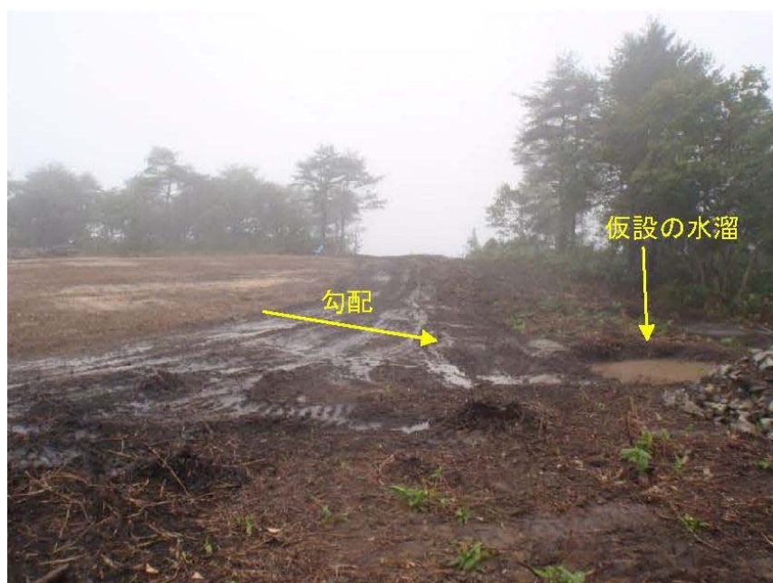
図 仮設の水溜の設置による環境保全措置の実施例
