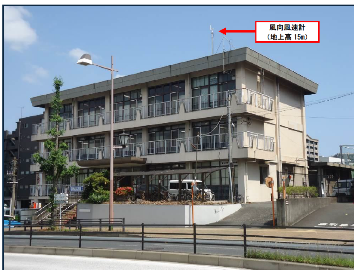
図1 小倉局の風向風速計の設置状況
