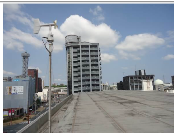
④西方向（西側 65mに 14 階建ビル）
