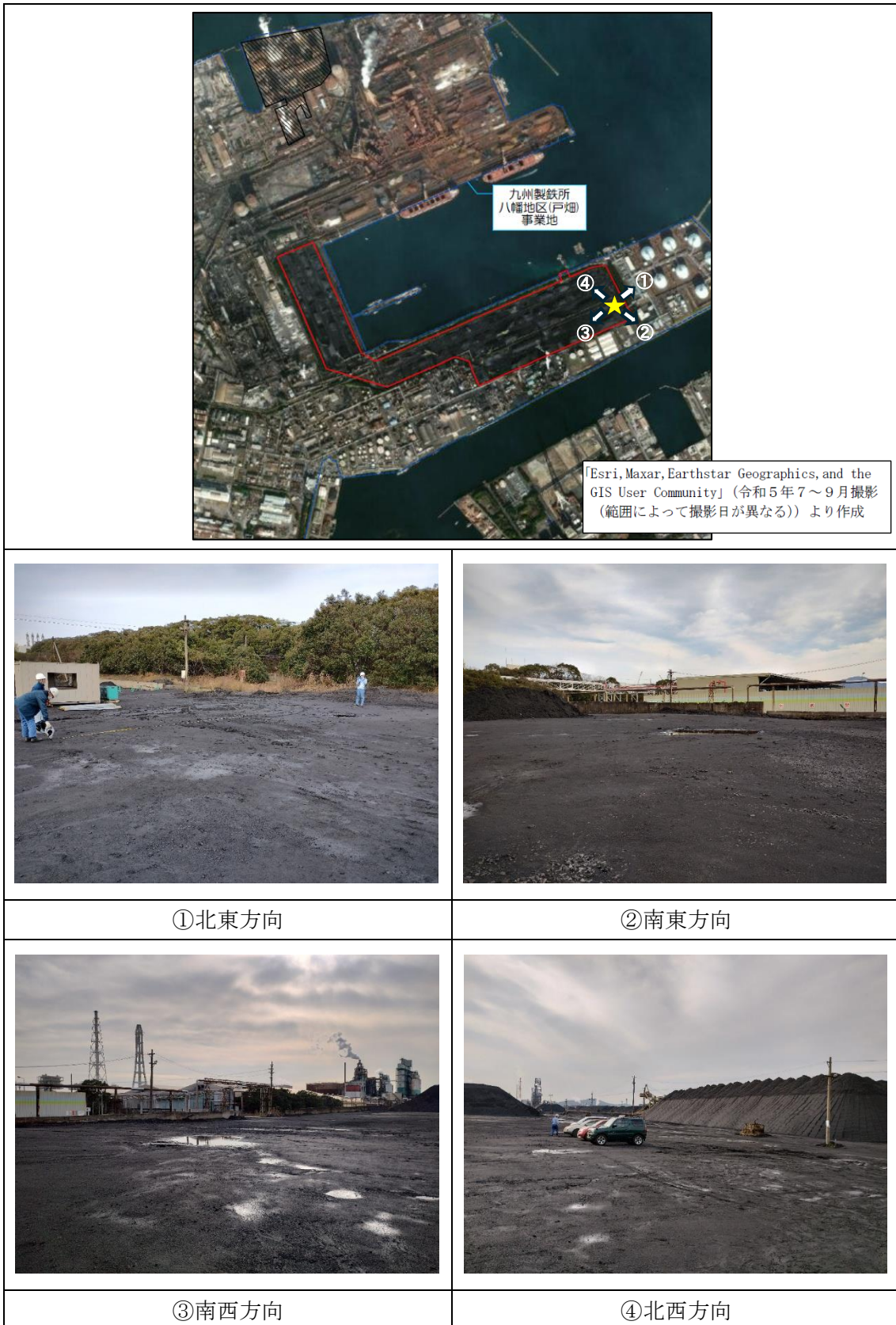
図 44-1 地上・上層・高層気象観測点（発電所構内）の状況
