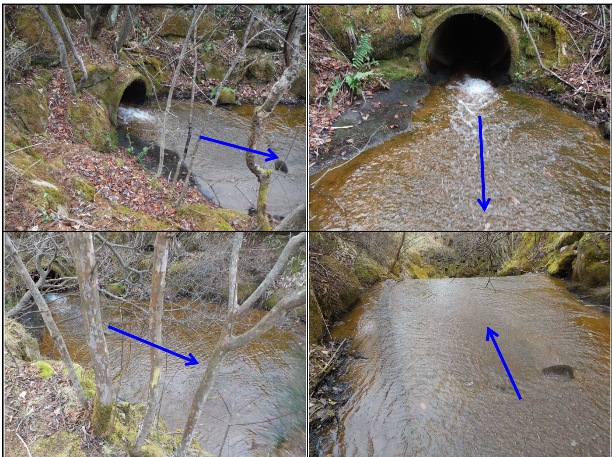
写真 1 調整池排出口（下流水路出口）
