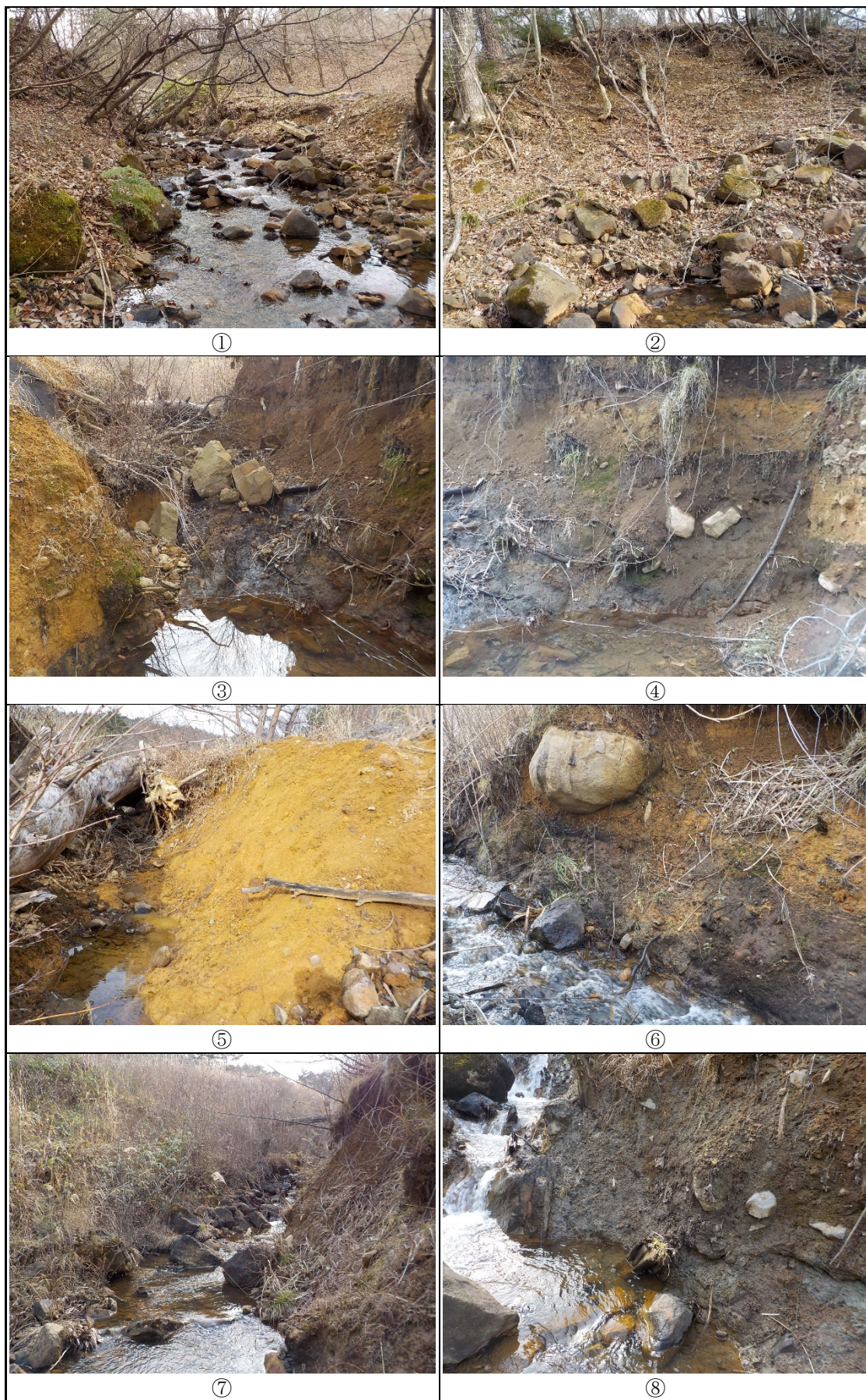
写真 2 河川周辺部の状況（調整池排出口～東八川 1）
