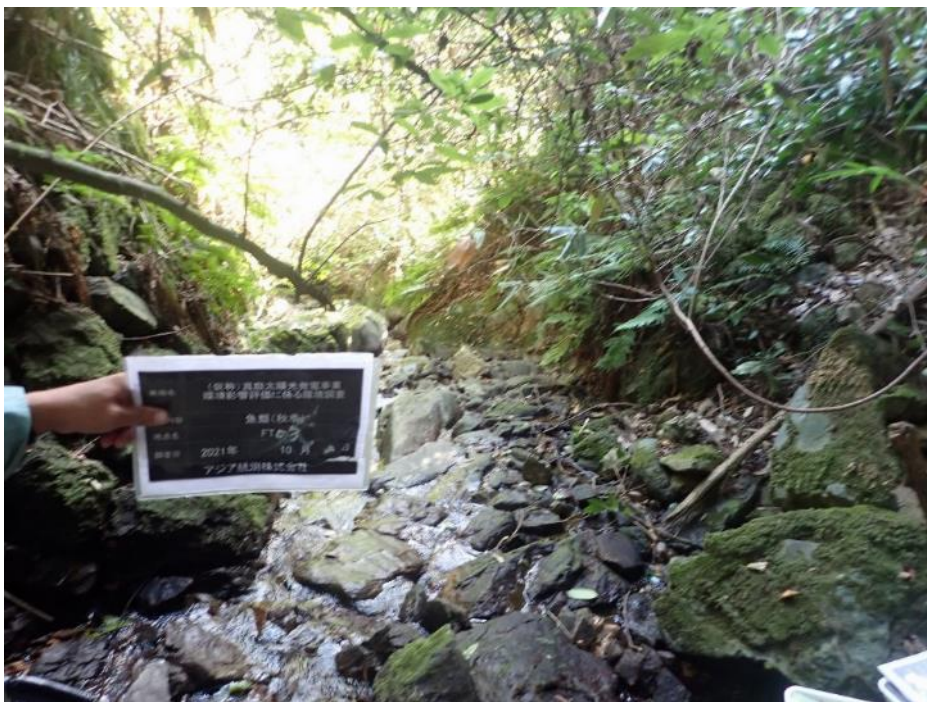
調整池から河川に流入する水路の状況（FT03）
