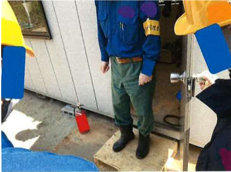
写真3 災害発生時に改善したステップ
