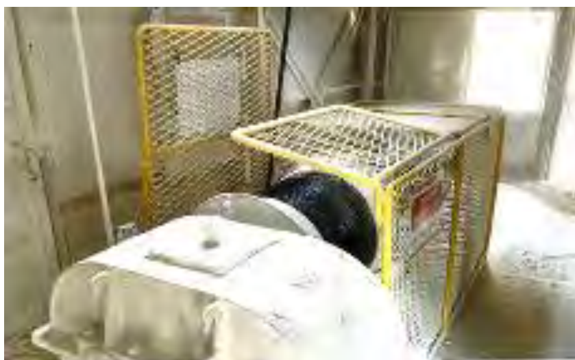
写真3：スキップウインチ周囲に安全柵を設置（令和4年2月1日完了）
