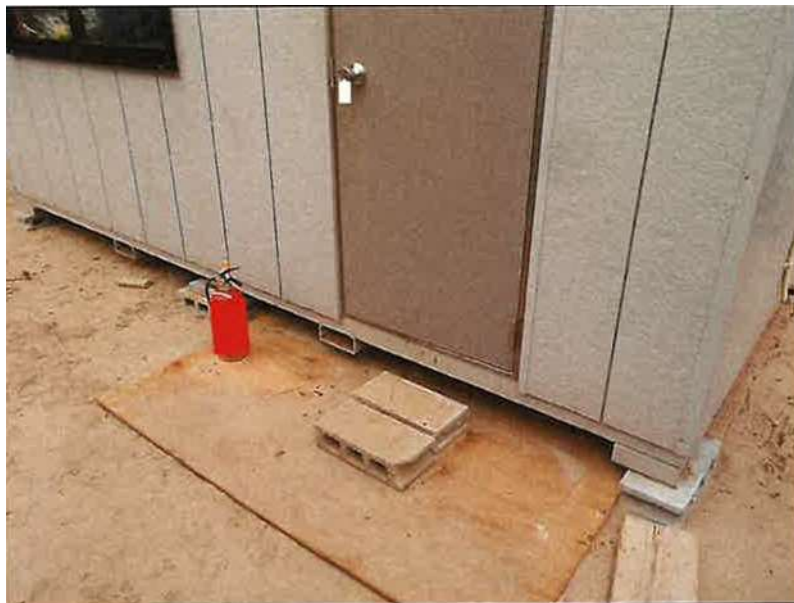
写真1 災害発生前にステップとして設置していたブロック
