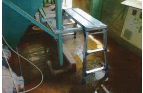
写真4 移動式作業足場(改良後)
