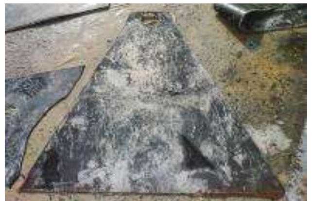
写真2 ゴムライニング
