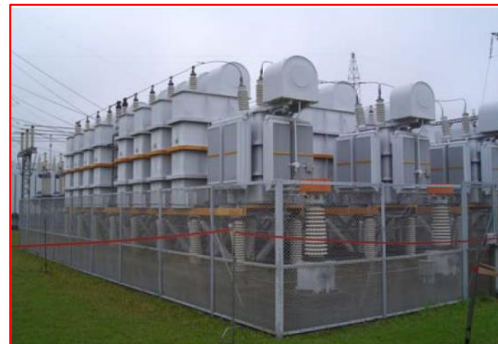
電力用コンデンサー
