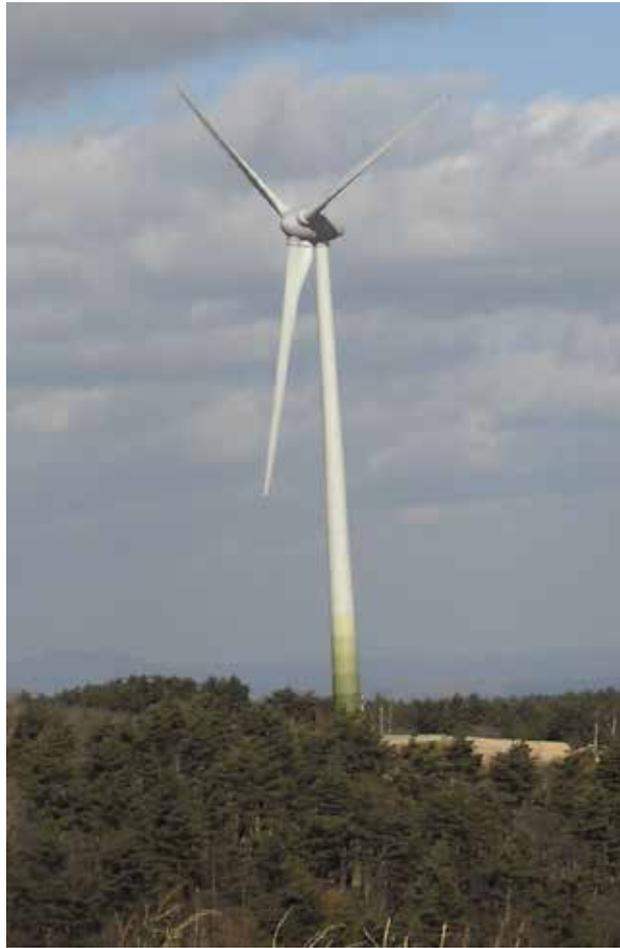
写真 3-2 周囲の景観に馴染むようにタワーにグラデーション塗装を実施した例
