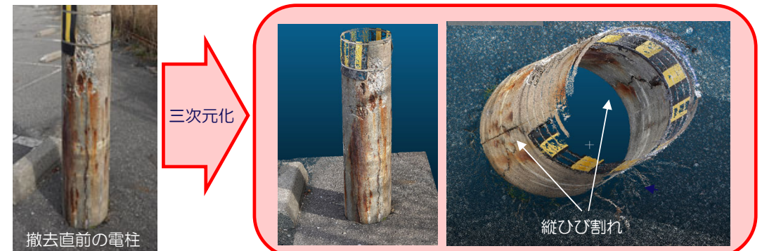
図1 現地で撮影したインフラ（電柱）画像からオフィスで詳細な解析が可能
