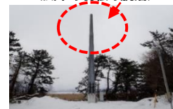
＜風車の羽根の脱落＞
