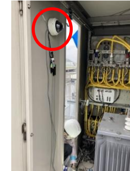
⑤可視カメラ (可動) 高圧機器等の 損傷等の監視
