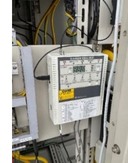
⑥漏れ電流センサ 低圧絶監 (漏れ電流) の監視
