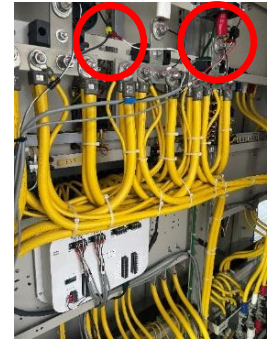
③電圧・電流センサ 低圧電圧・負荷電流の監視
