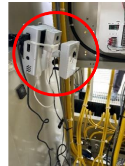
④サーマルカメラ 高圧機器等の 過熱監視
