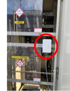
②高圧絶縁センサ 高圧機器の絶縁監視
