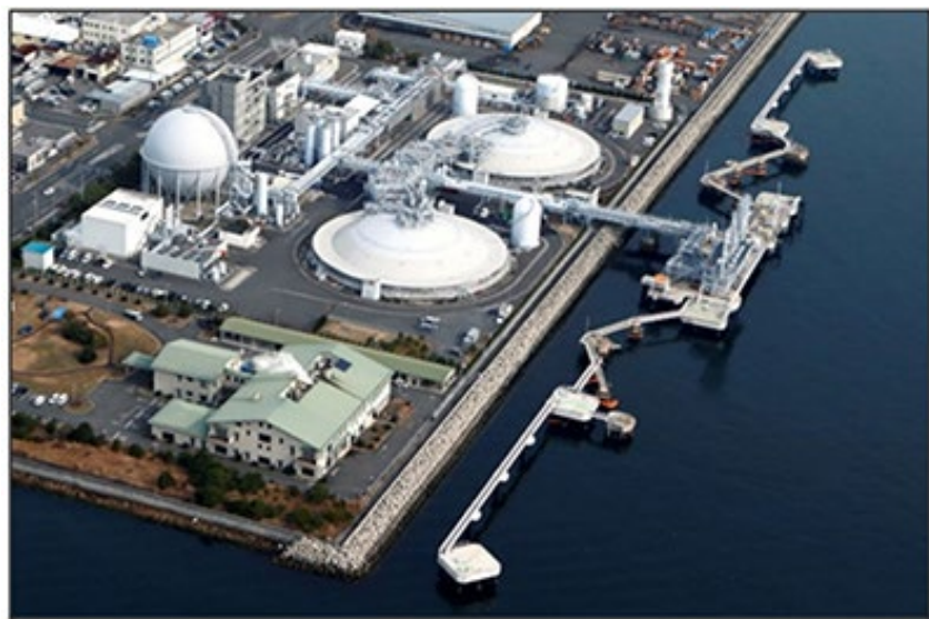
LNGプラント全景
