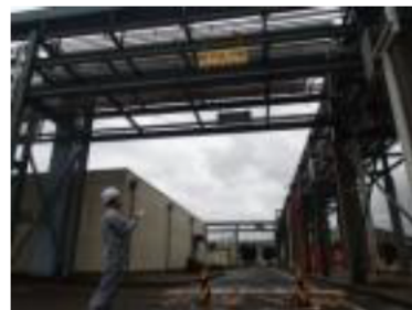
図1.地上からの目視 (一次点検)
