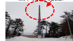
＜風車の羽根の脱落＞
