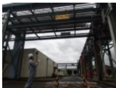
図1.地上からの目視 (一次点検)
