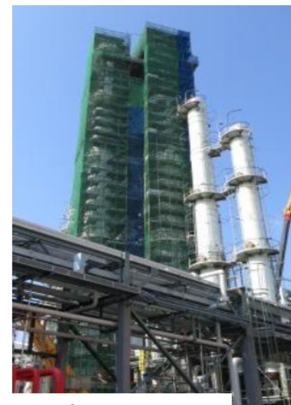
図3.高所足場設置
