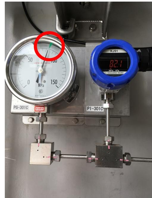
圧力計による変動管理
