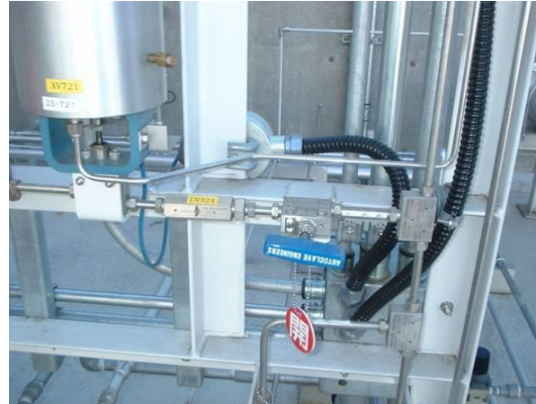
● 遮断弁、逆止弁
