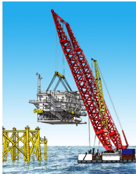
図 3-7 サブステーションの施工イメージ
