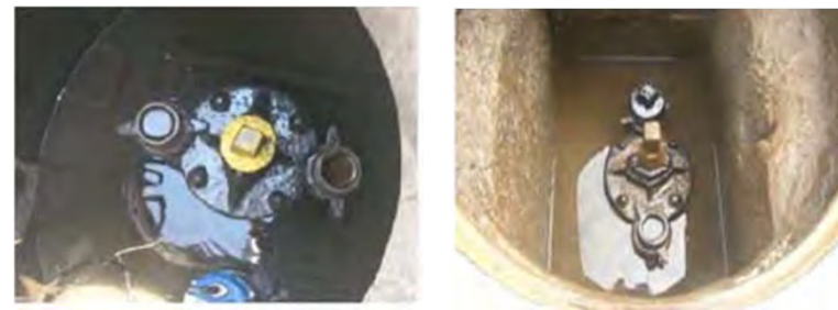
消火栓(工水) 名古屋市内に設置
