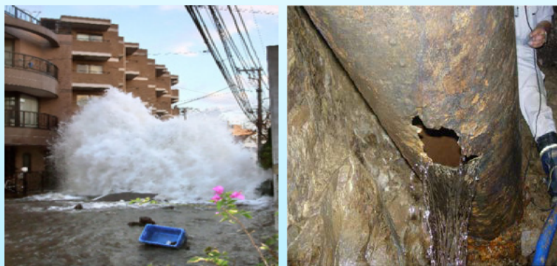
老朽化による事故の例
