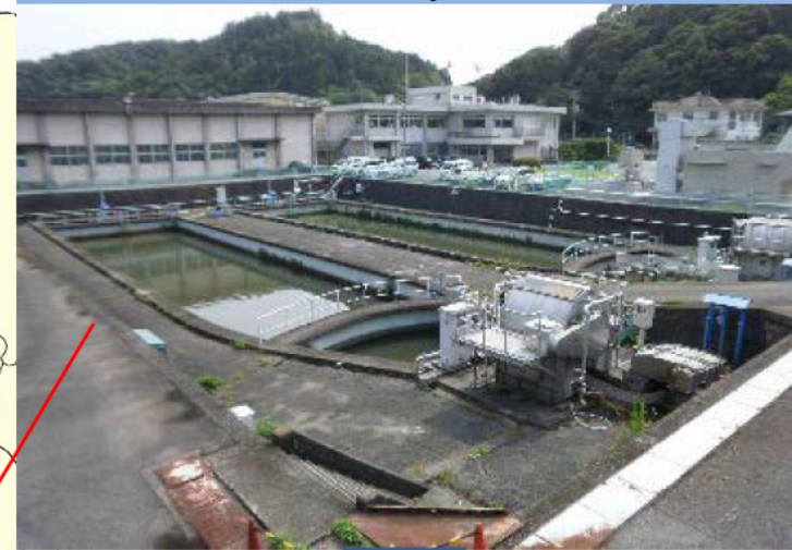
本郷取水場 (沼田川が氾濫, 場内浸水)
