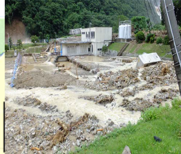
二級水源地調整池管理棟 （土砂が流入）
