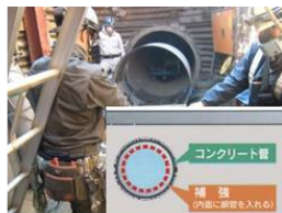
耐震対策の例：管路の耐震補強
