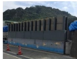
浸水対策の例：施設のかさ上げ
