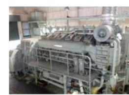
停電対策の例：自家用発電機
