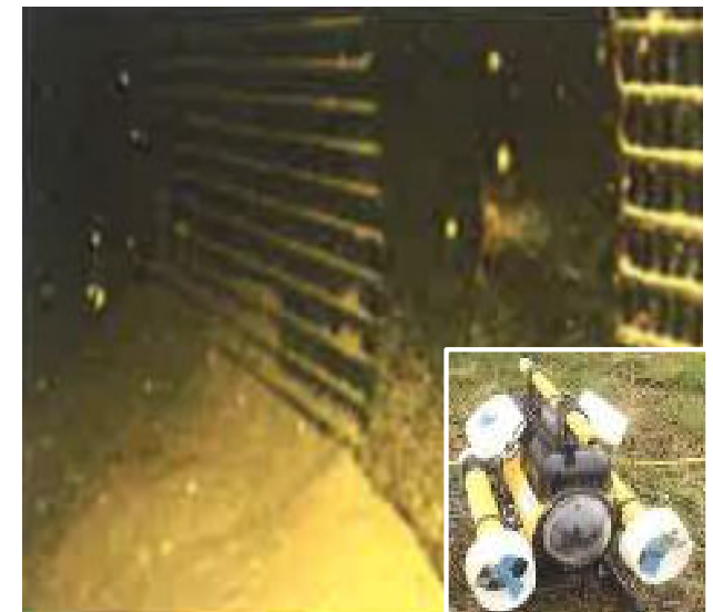
②水中ロボットでの撮影事例
