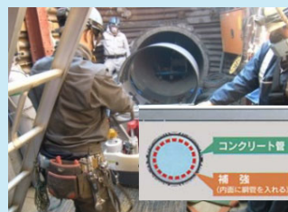
例：管路の耐震補強
