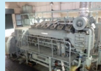
例：自家用発電機の整備
