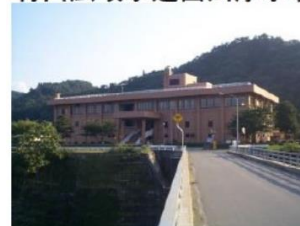
村山広域水道西川浄水場
