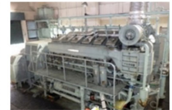
例：自家用発電機の整備
