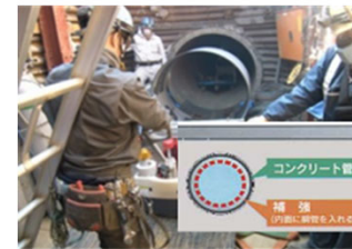
例：管路の耐震補強
