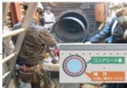
例：管路の耐震補強
