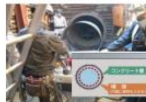
例：管路の耐震補強
