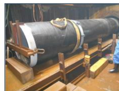
耐震化: 耐震管の布設
