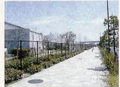
長谷川鉄工（株）様の事例 透過性のあるフェンスを用い、防犯・安全性にも配慮しながら、みどり豊かな景観を演出している。
