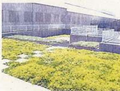
(株)大阪チタニウムテクノロジーズ様の事例 パレット型緑化資材で屋上緑化を行っている例。他にも、軽量の人工土壌や自然土壌を用いる例もある。
