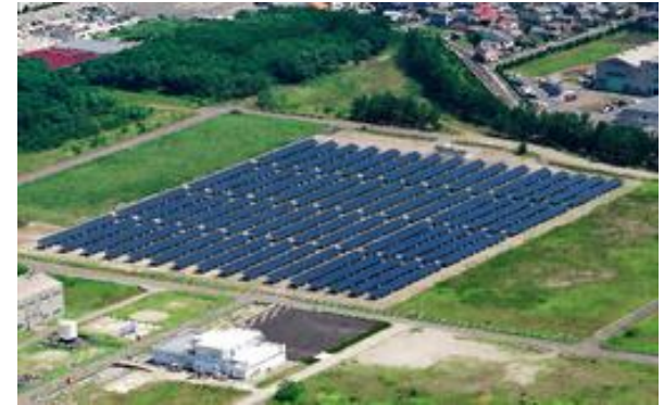
新潟雪国型メガソーラー発電所(新潟県、昭和シェル石油)
