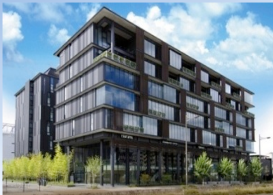
京都リサーチパーク9号館内に設置
