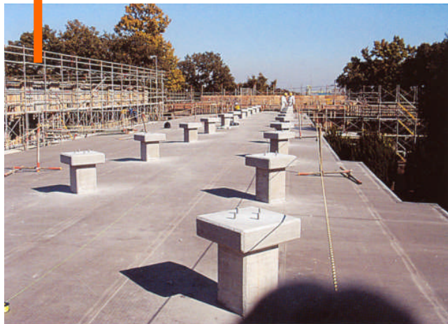
基礎工事完成
