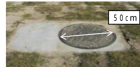
【実際の点検孔】
