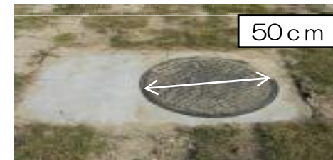
【実際の点検孔】
