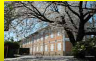
【富岡製糸場】 (群馬県富岡市)
