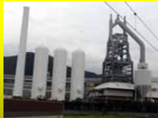
【八幡製鉄所東田第一高炉】 (福岡県北九州市)
