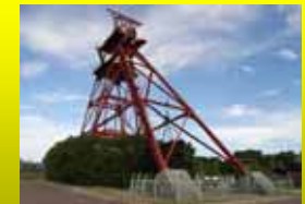
【旧三井田川鉱業所竪坑槽】 (福岡県田川市)
