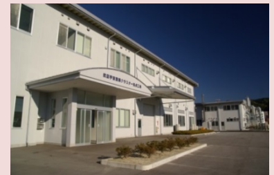
クラスター拠点整備工場
