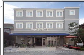
【川越市】 『旧鶴川座再生・利活用事業』 認定：2019.4.4
