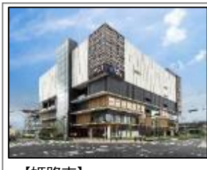
【姫路市】 『姫路キャスティ21stアゾンBブロック商業施設整備事業』 【テラッソ姫路】 認定：2015.6.12
