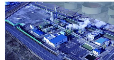
苫小牧CCS実証試験センター
