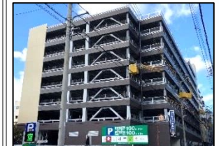
【高松市】 『大工町ものづくり育成店舗整備事業・大工町立体駐車場整備事業』 認定：R3.3.16
