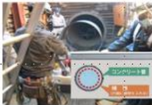
例：管路の耐震補強
